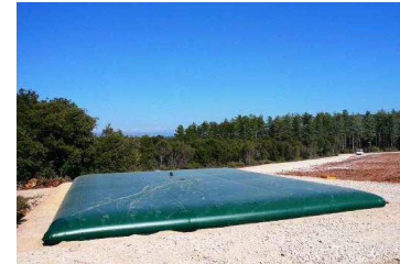
Figure 145 : Photographie d'une citerne
